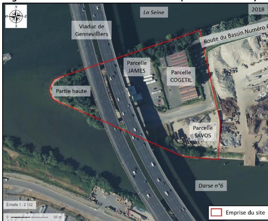
Figure 1 – Présentation de la zone d'étude (avant démolition)
