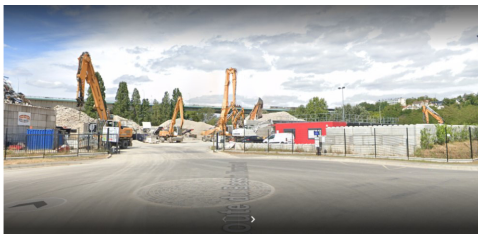
Figure 51 : Caractérisation des engins de travaux sur zones process et stockage MAZEAU RECYCLAGE
