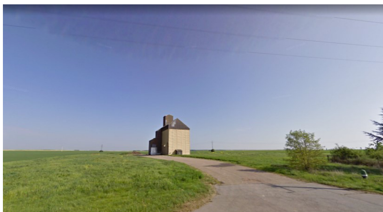
Figure 12 : Site déporté NatUp de Serez (27) : vue de l’entrée du site (silo de stockage de grains)
