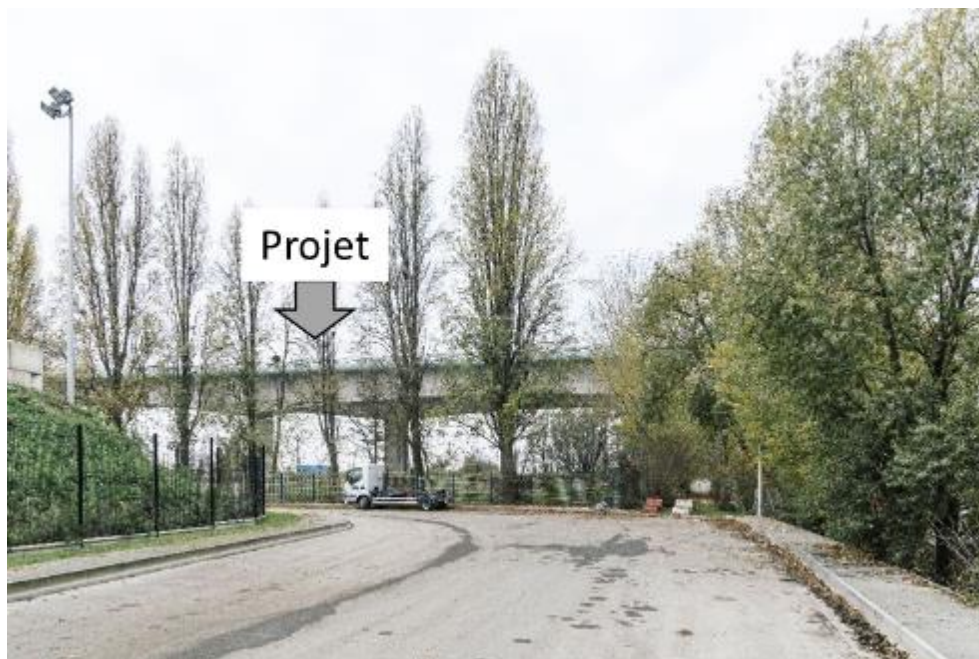
Figure 66 : Vue depuis la route du bassin n°6
