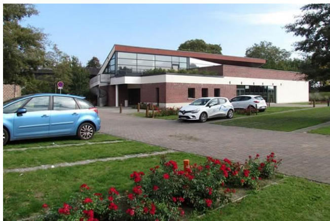
Photo 13 : Exemple de parking engazonné (source : o2d-environnement)
