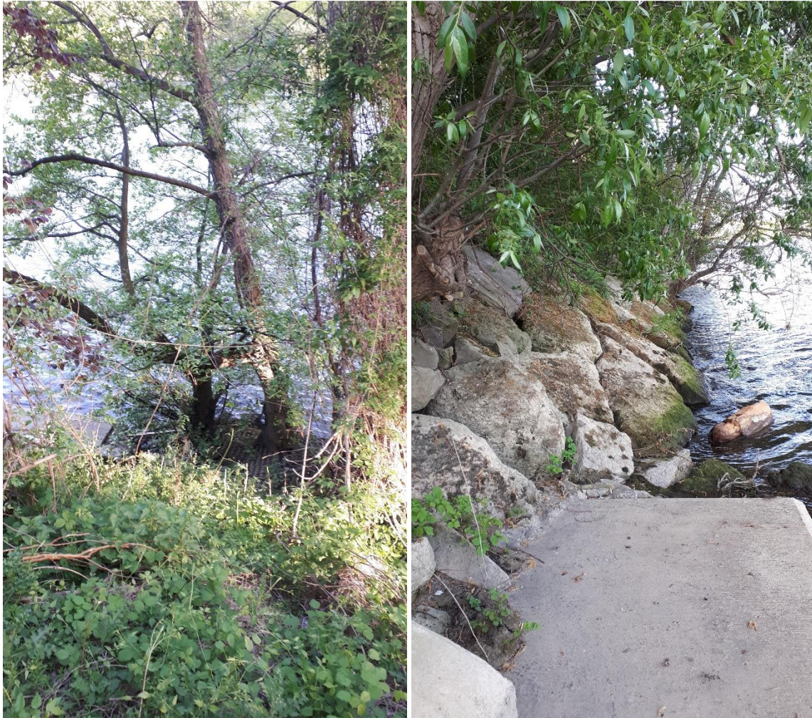
Photo 3 – Boisement en pied de berge entre les enrochements (Alïsea 2020)
