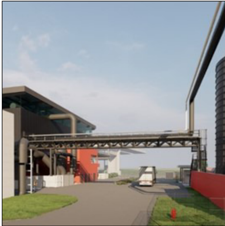
Figure 36 : Portique reliant les bâtiments de préparation et la zone digestion
