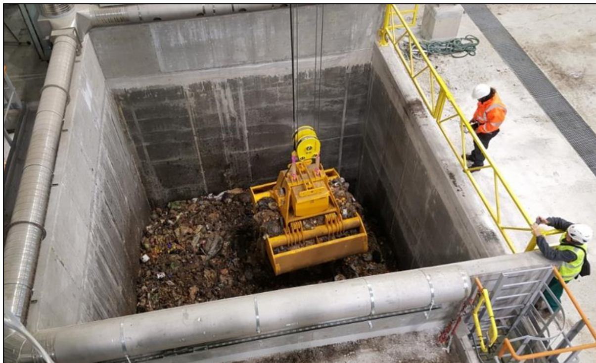
Figure 26 : Exemple de vue Fosse et Godet du pont en cours de chargement
