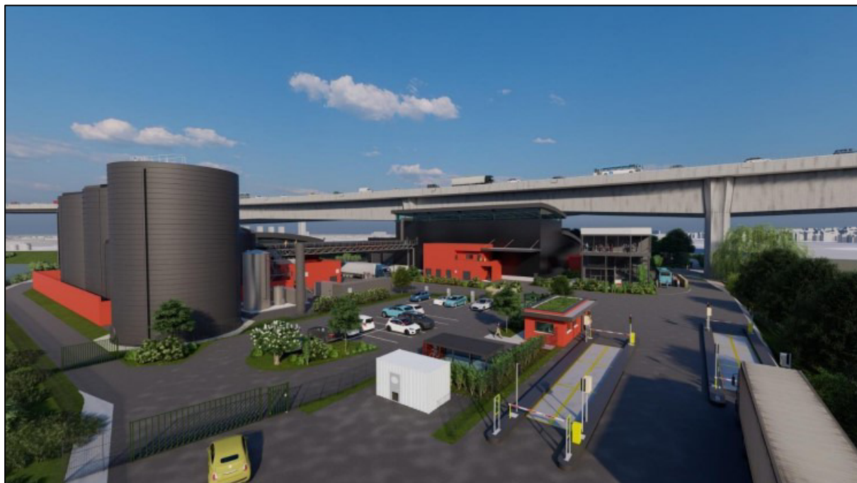
Figure 1 : Vue générale du site
