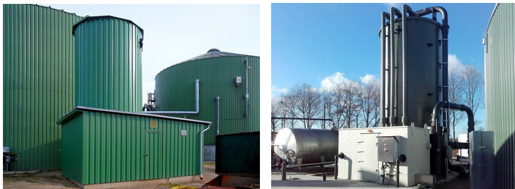
Figure 68 : Installation Unité Désulfuration
